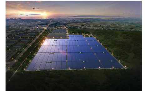
국토교통부와 새만금개발청은 지난해 12월 새만금에서 육상태양광 발전시설 1구역의 준공식을 개최했다. 새만금 지역에 처음 준공하는 재생에너지 생산을 위한 태양광 발전시설이다. 사진은 새만금 육상태양광 발전시설 현장 조감도. [사진 국토교통부]
